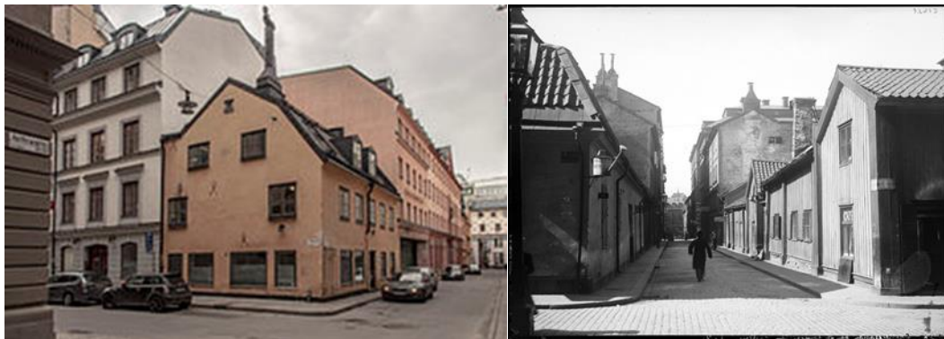
Kvarteret Bryggaren (hörnhuset från 1727) och Svärdfisken (sent 1800-tal), på Apelbergsgatan.
