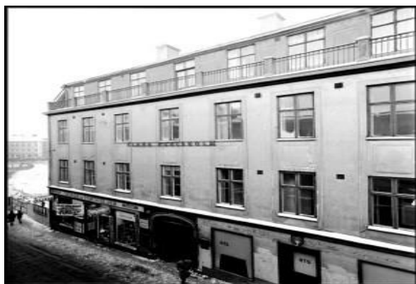
Det numera rivna huset på Hamngatan 36.
